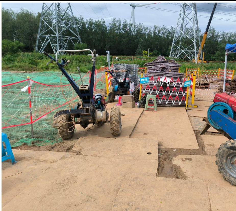
说明：塔基区 临时苫盖 铺设钢板 2025 年 9 月
