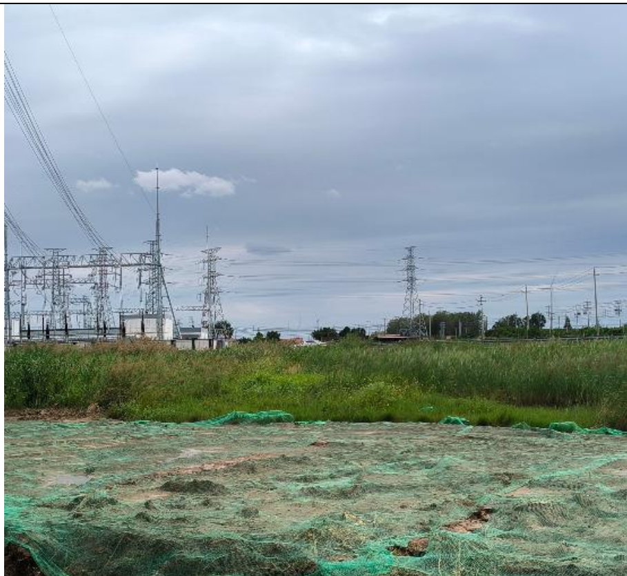
说明：塔基区 临时苫盖 2025 年 9 月
