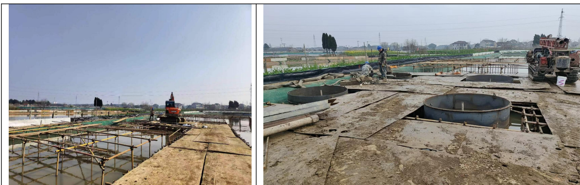
现场排架钢护筒施工
