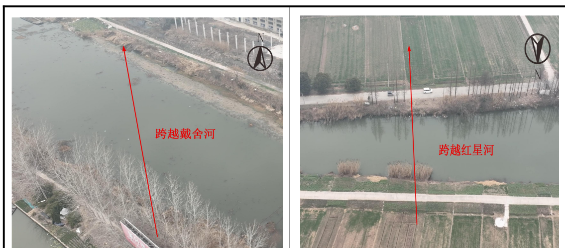
图 1.1-10 本工程架空线路跨越情况照片
